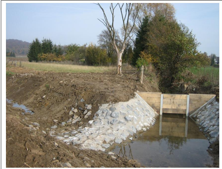
Hochwasserentlaster Tiefensieksbach mit einer 0,5 Meter hohen und 4 Meter breiten Überlaufschwelle zum Limbach
